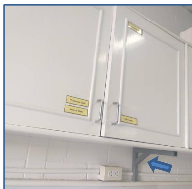
ทำฐานรองรับชั้นลอยป้องกันการหล่น
